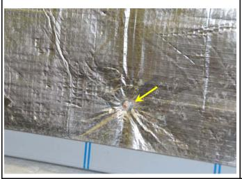
5- Placer la bride isolant sur la cuve puis la plier en appuyant dessus.
